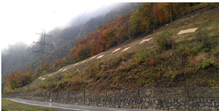
Vue d'ensemble de la digue
